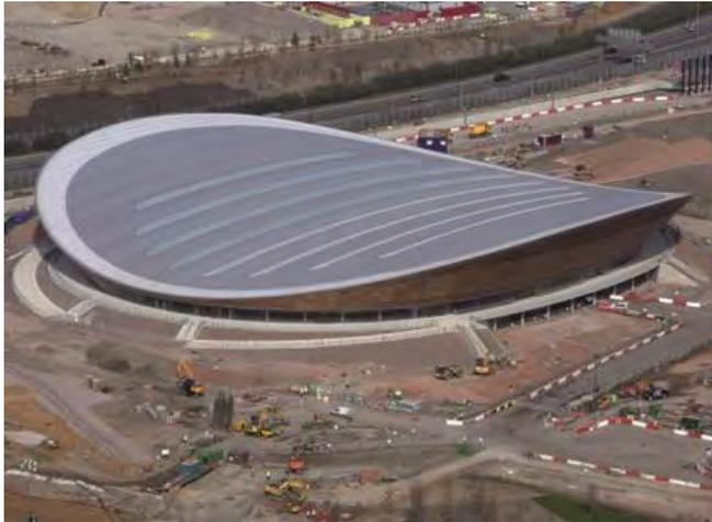
Il basso edificio del Velodromo ha un volume contenuto ed una struttura estremamente leggera che riduce sensibilmente la quantità di materiali impiegati.
